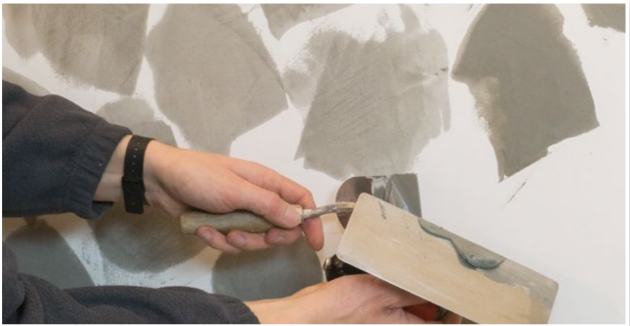
Mit wenig Material auf der Kelle arbeiten.
