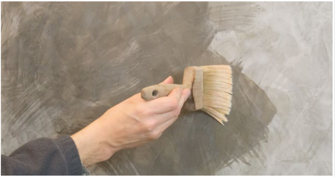
Glätteseife auf Teilstücke auftragen.
